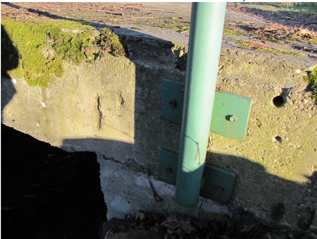
Obr.č.9: Uchycení zábradlí, mech na bocích konstrukce.
