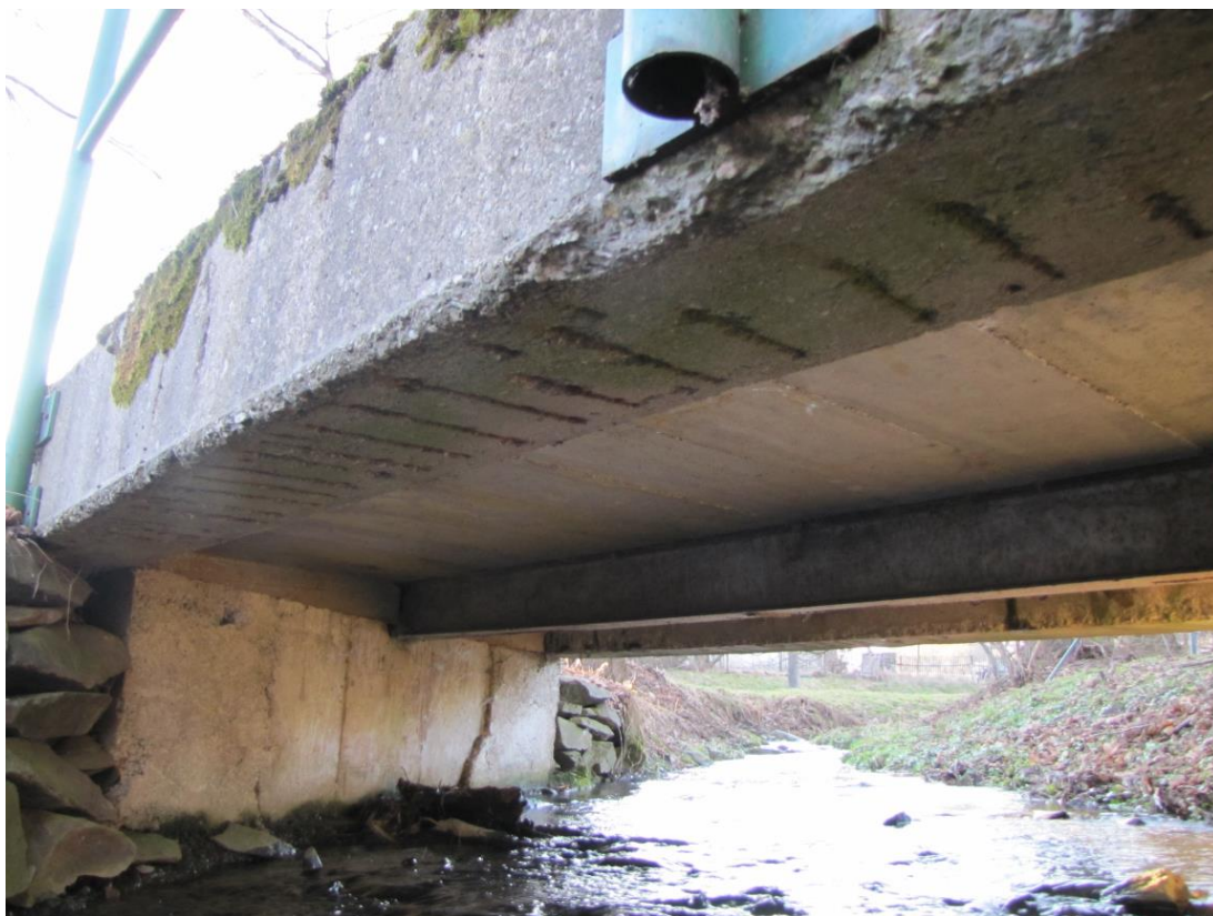
Obr.č.9: Pohled na NK - obnažená a zkorodovaná výztuž
