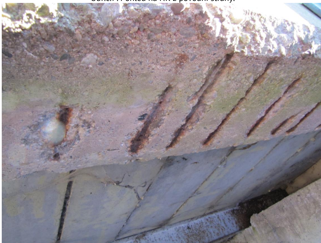
Obr.č.8: Pohled na NK - obnažená a zkorodovaná výztuž.
